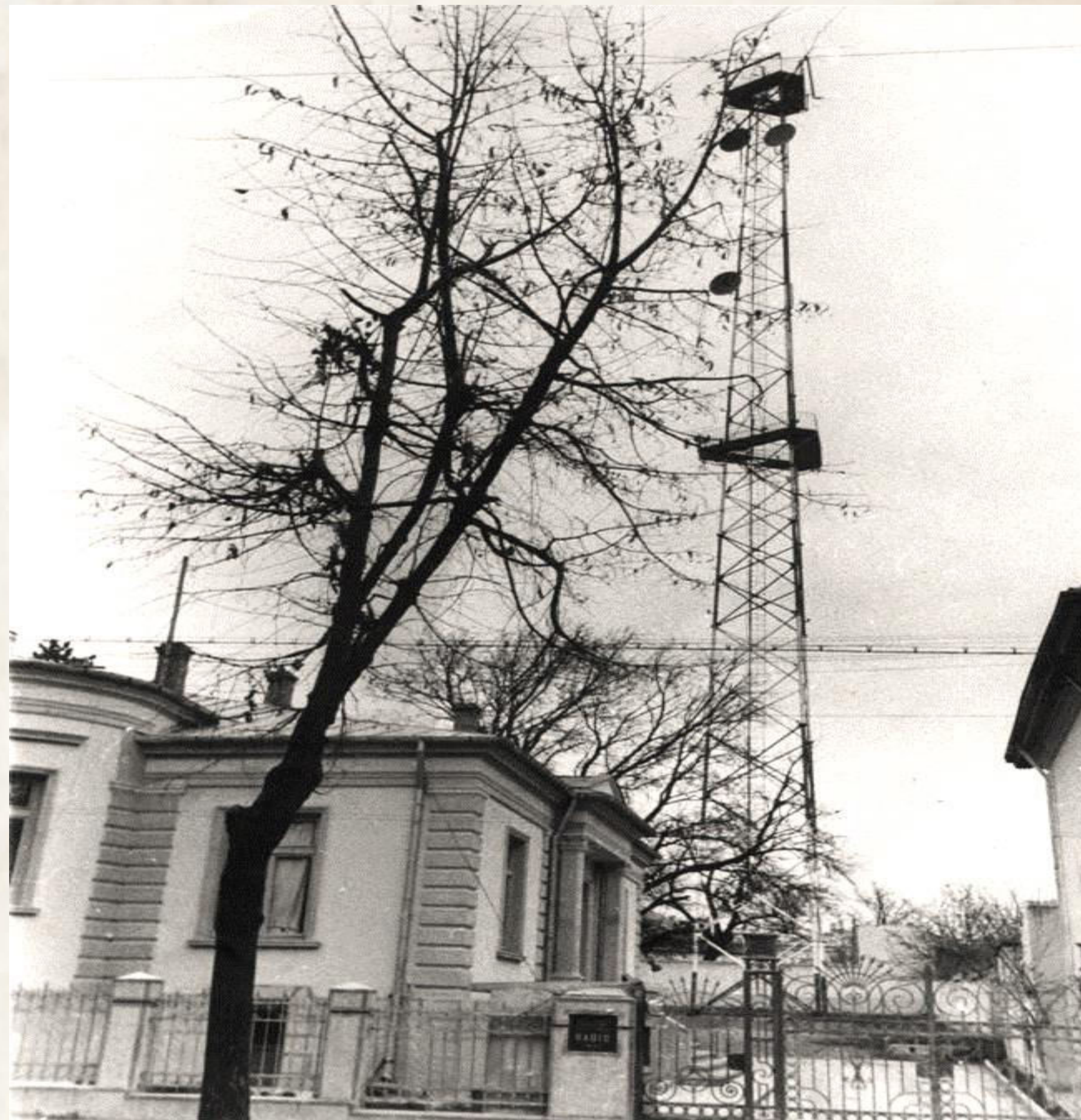
Clădirea din 1956 a Radio Iași, sursa: rador.ro
